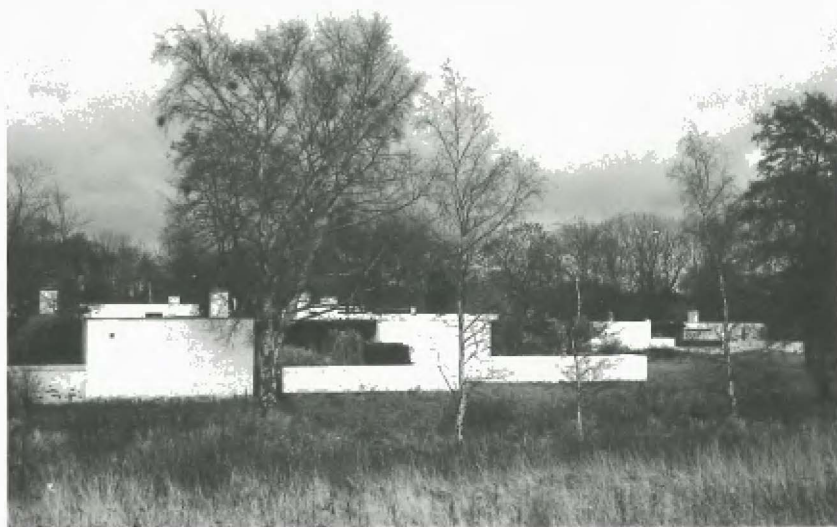
Ved Stampedammen. Opført 1962. Arkitekter: Carl R. Frederiksen, Mogens Hammer, Henning Moldenhawer og Hubert Paulsen.
