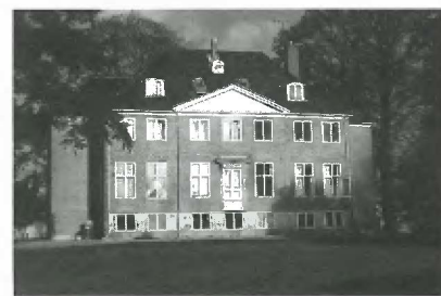
Nebbegårds hovedbygning. Opført ca. 1805.
