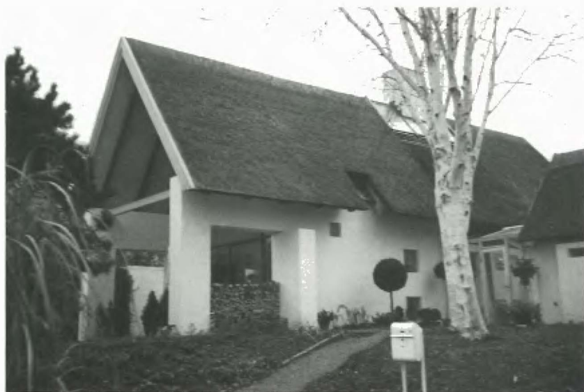
Linstowsvej 1. Opført 1974. Arkitekt: Nils Fagerholt.
