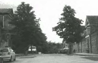
Gl. Hovedgade med det tidligere apotek på venstre side og forrest på højre Postholdergården.
